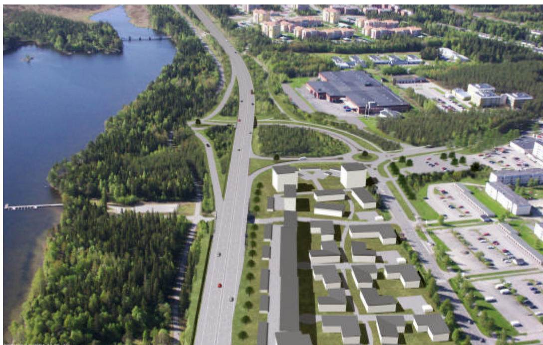
Mariestrand från norr, Mariehemsvägens anslutning till den ombyggda Kolbäcksvägen/E4.
